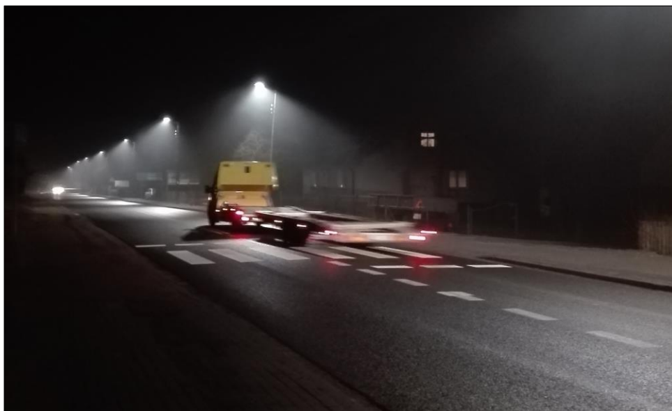
Zmodernizowane oświetlenie LED na ul. Pomorskiej w Suchaniu
