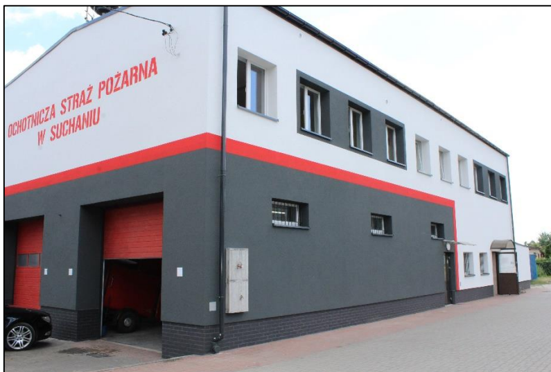
Budynek OSP w Suchaniu po termomodernizacji
