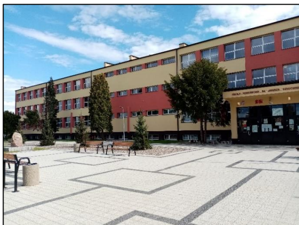
Ściana frontowa budynku szkoły
