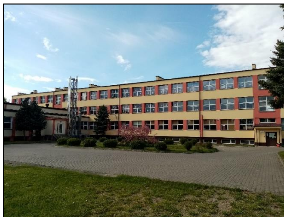
Ściana budynku szkoły od strony boiska
