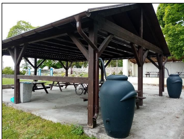
Plac zabaw w Nosowie – zbiorniki na deszczówkę
